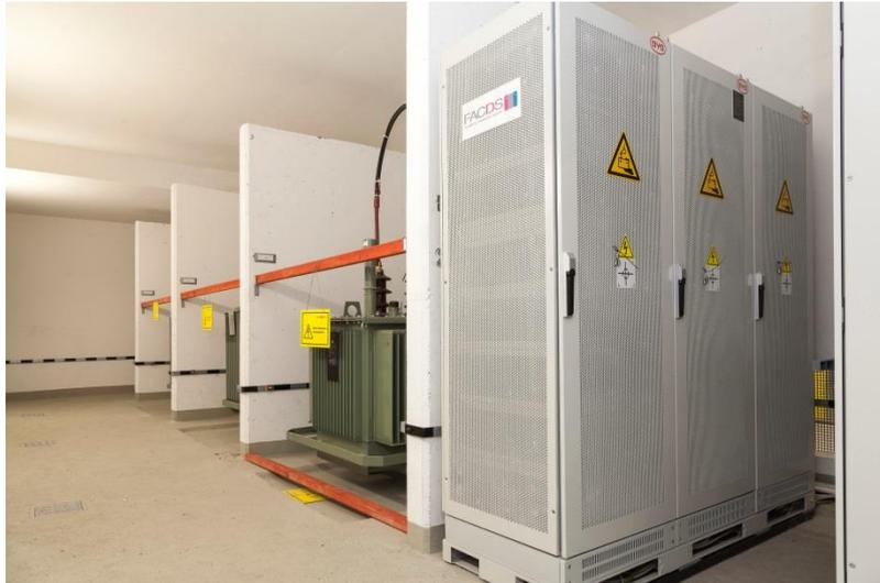
Abbildung 6: Netzspeichersystem in der Trafokoje im Forschungsprojekt FACDS
